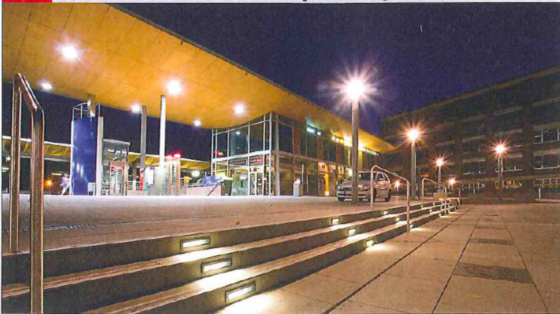
Abb. 1 In Rüsselsheim ist die Rekommunalisierung bereits erfolgreich abgeschlossen
