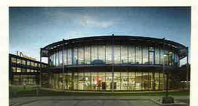
Die Firmenzentrale des Büromöbelherstellers König + Neurath in Karben
