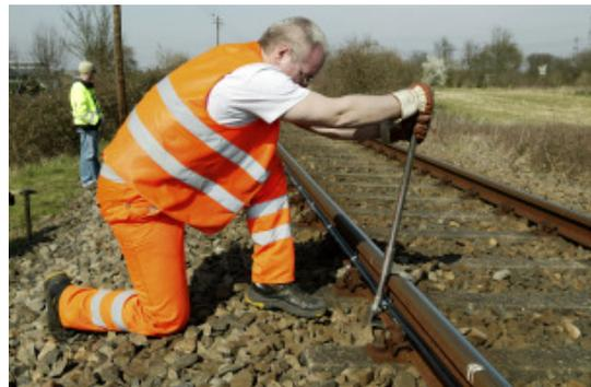
DuoTrack® ist eine innovative All-in-One-Systemlösung für die schnelle, kostengünstige und zukunftssichere Streckenverkabelung nicht elektrifizierter Regionalbahnstrecken. Von links oben nach rechts unten: das DuoTrack®-Kabel, das verlegte Kabel, der Spezialzug zur Verlegung sowie die Befestigung des Kabels mit den speziellen Halteklammern der Firma Contec.
