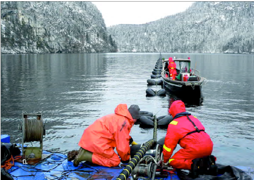
Ruhiges Wasser: Einige Tage nach dem Unwetter konnte die Kabelverlegung abgeschlossen werden
