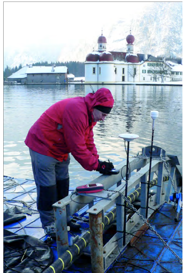
Lagepeilung: Während des endgültigen Absenkens des Kabels auf den Seegrund kontrollierte das Team dessen Lage mit einem Satellitennavigationsgerät
