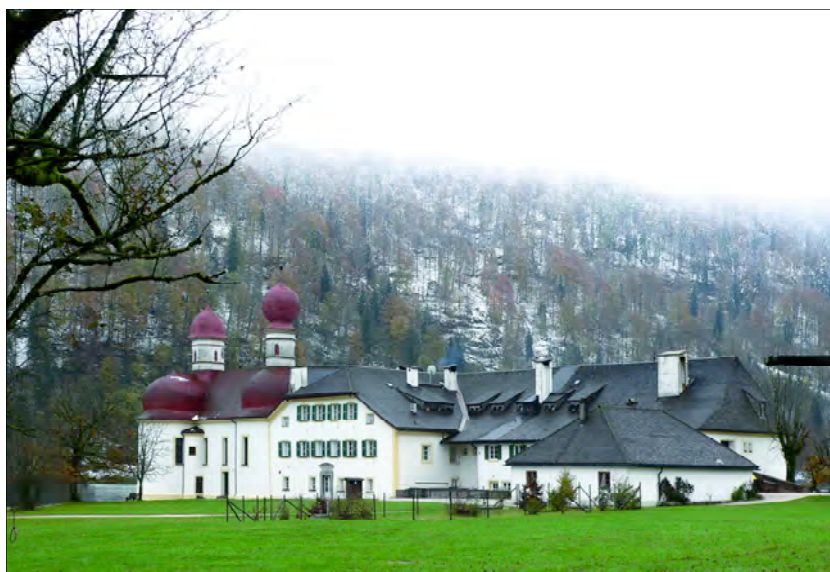
Aufgrund eines neuen Seekabels und einer leistungsfähigeren Transformatorstation ist seit Anfang 2008 der Stromengpass auf St. Bartholomä beseitigt; im Bild die im 12. Jahrhundert gegründete Kirche und das ehemalige Jagdschloss
