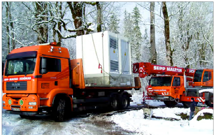
... damit die Transformatorstation (hier ohne Transformator) ihr Ziel erreicht
