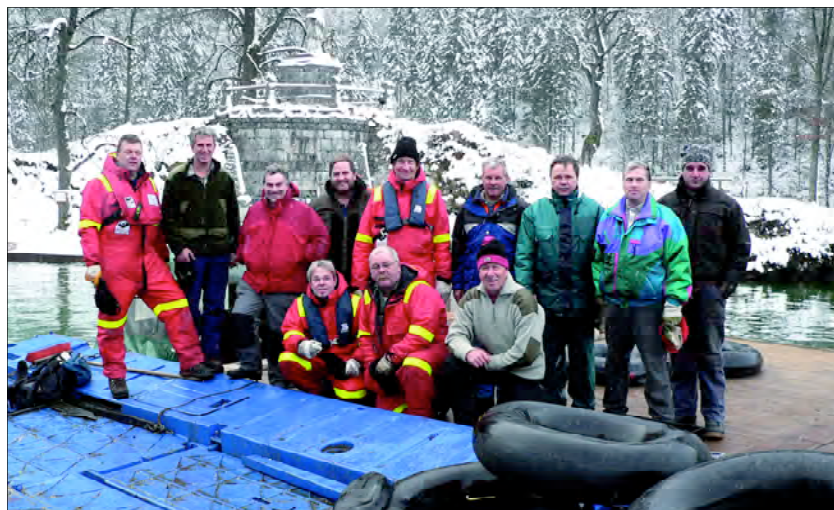
Alle Beteiligten haben über Tage hinweg ihr Bestes gegeben und nicht nur technischen Problemen, sondern auch der Kälte getrotzt. Die geglückte Kabelverlegung ist für alle eine große Erleichterung
