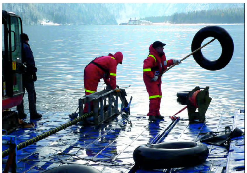
Bergung des Kabels. Teils wieder auftauchende Schläuche wurden vom Kabel entfernt und eingesammelt
