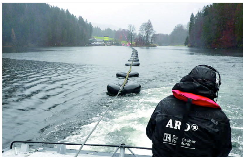
Gelungener Auftakt: Auf Gummischläuchen schwimmt das Kabel, das langsam von einem Boot nach St. Bartholomä gezogen wurde. Nach seiner genauen Positionierung sollte das Kabel in den See gelassen werden
