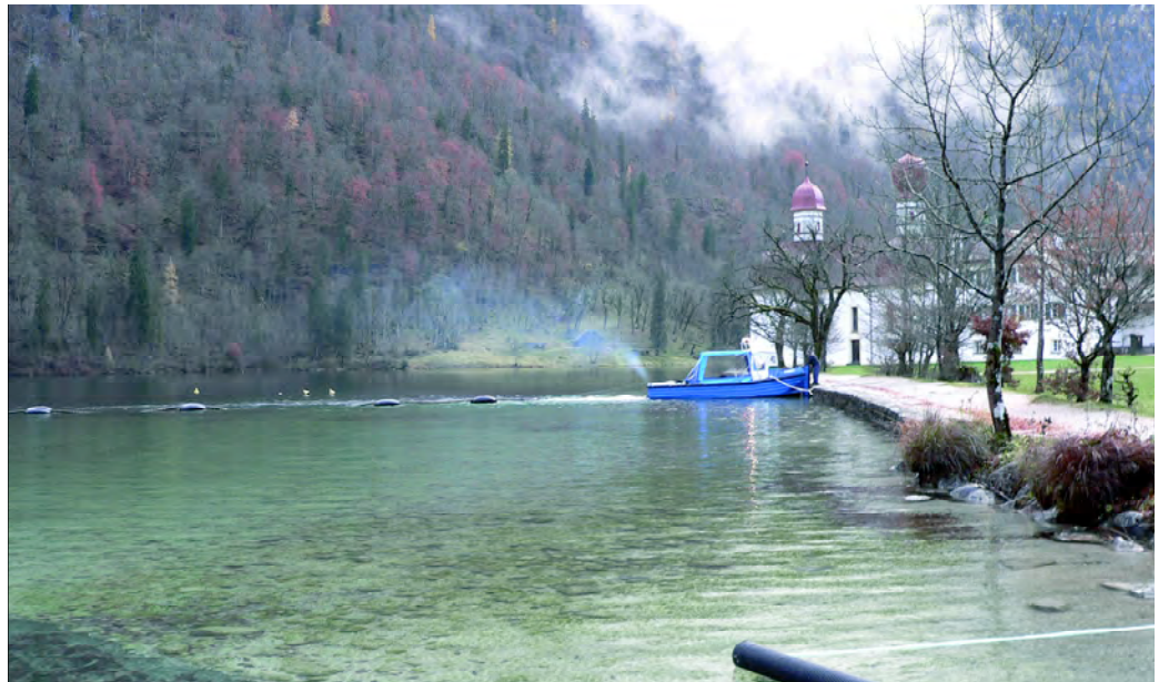
Nur einen Tag brauchte das Team, um das 5,5 km lange Kabel auf die tausend Gummireifen zu schnallen und über den See zu ziehen
