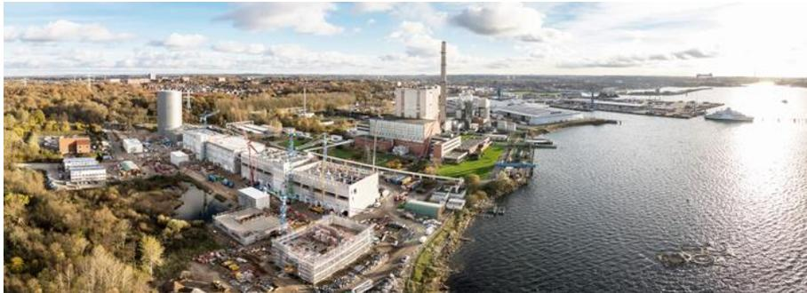
Der Wärmespeicher und der Elektrodenkessel des Küstenkraftwerks Kiel stehen schon, die Hallen für die 20 KWK-Motoren sind fast fertig.
