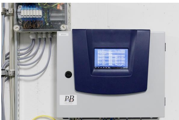
Alle Wärme- und Kälteflüsse managt die varmeco-Regelung VarCon380 Pro, die mit Modulen entsprechend angepasst wurde.
