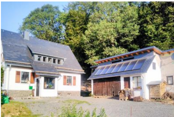
Die Besitzer dieses 50er-Jahre-Forsthauses heizen CO 2 -neutral – mit Solarthermie und einem Holz-Kombi-Kessel.
