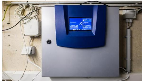
Der varmeco-Systemregler VarCon380 steuert das Wärmemanagement und ermöglicht den Fernzugriff auf die Betriebsdaten und historische Werte.
