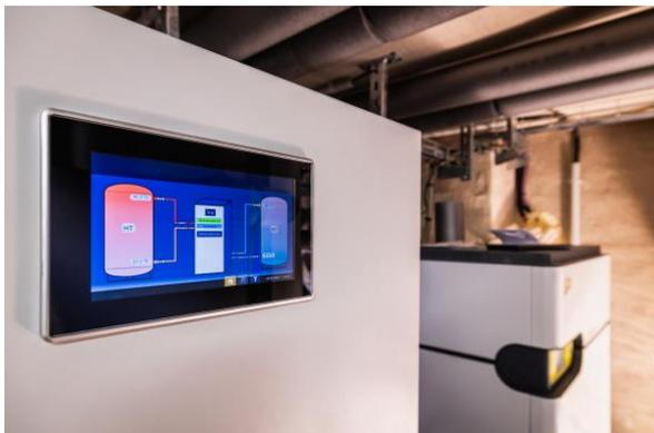
Die eXergiemaschine (links im Bild) sorgt für einen Temperaturhub von etwa 35 oder 40 °C auf über 60 °C und entlastet so die Wärmepumpe.
