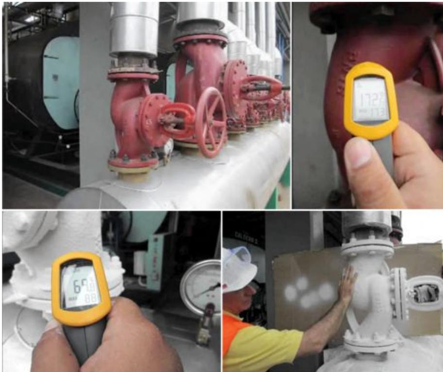
Vorher (oben) und nachher (unten): Die Senkung der Oberflächentemperatur um ca. 100 Grad demonstriert die Isolationswirkung und reduziert gleichzeitig das Verletzungsrisiko. (Fotos: ThermaCote)
