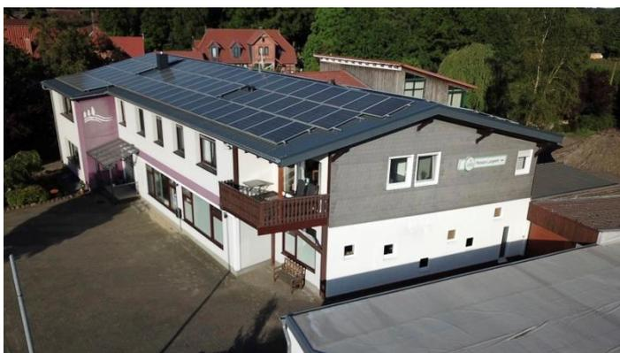
Aus diesem Gebäude aus den 1960ern haben Jörg Langrehr und seine Familie ein Effizienzhaus gemacht. Dank Wärmepumpe und eXergiemaschine arbeitet die Heizung nun CO<sub>2</sub>-frei und die PV-Anlage liefert mehr Strom, als im Jahresdurchschnitt benötigt wird. (Bild: Jörn Kaminski)
