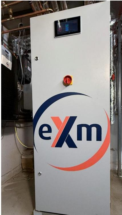
Zur Warmwasserbereitung und für die Hochtemperatur-Heizkreise ist eine eXergiemaschine als „Wärme-Booster“ installiert. (Bild: Jörg Langrehr)
