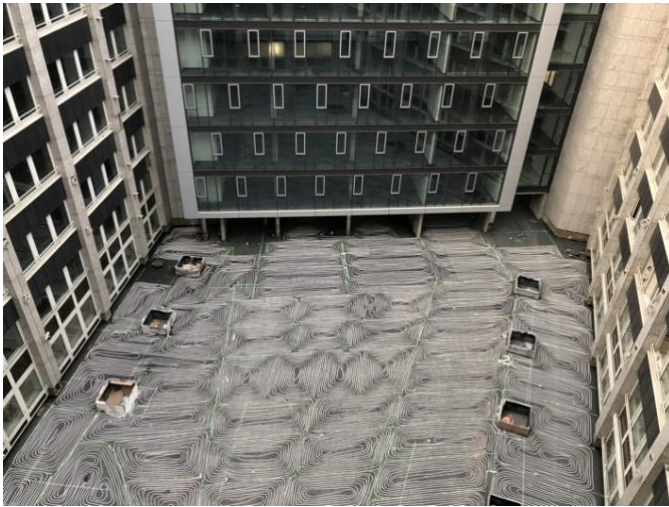
Installierte cuprotherm-Flächenheizung (Quelle:
